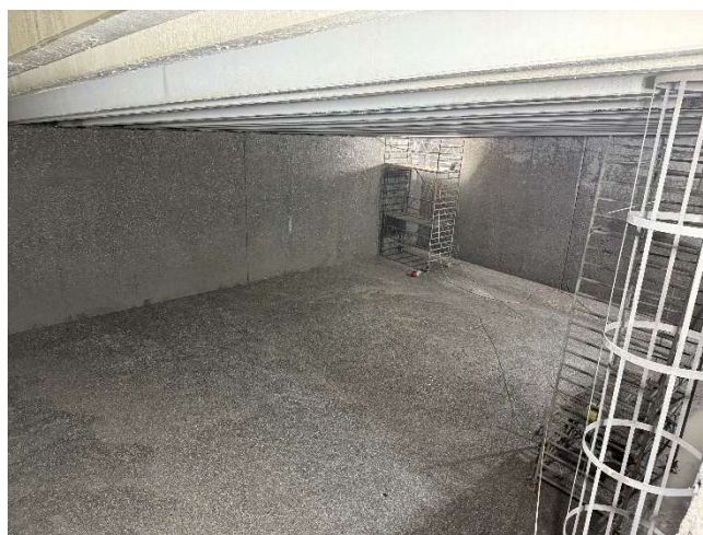
Stand der Abbrucharbeiten
